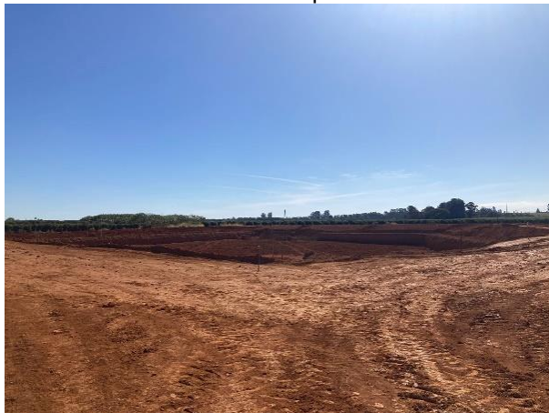
Figura 14: Vista do local onde está sendo construído um piscinão.
