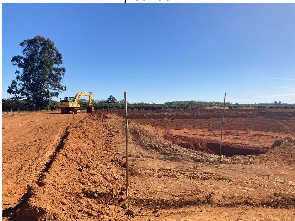
Figura 15: Vista da execução da construção do piscinão.
