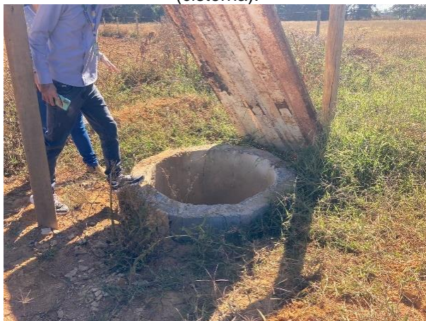
Figura 10: Vista de um dos pontos de captação (cisterna).
