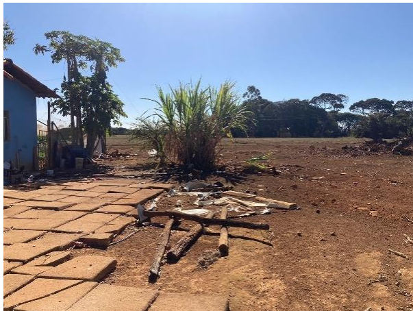
Figura 08: Vista da fossa negra da casa do caseiro.
